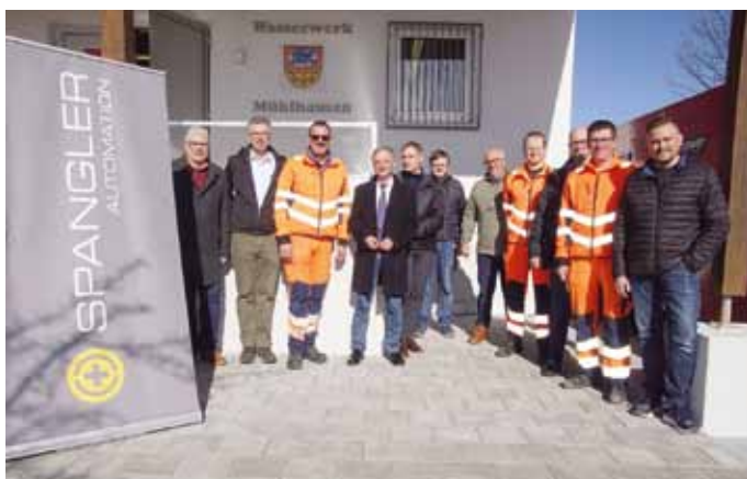
Inbetriebnahme des Notstromaggregats am Wasserwerk Mühlhausen
